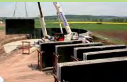
▲ Anlieferung in Innenladerpaletten
