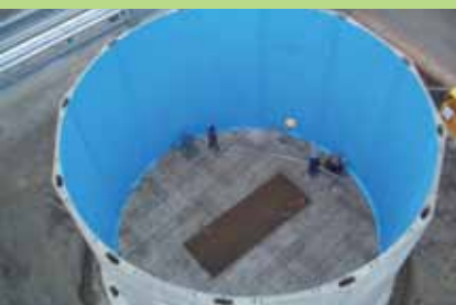
▲ Fertigteilbauweise mit Schutzauskleidung
