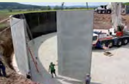
▲ Fertigteilmontage
