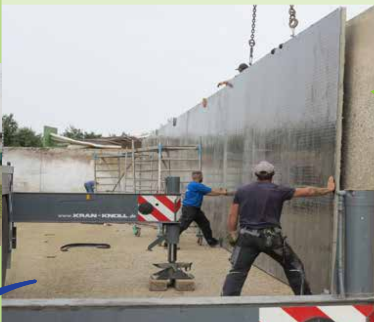
▲ Herstellung im Fertigteilwerk mit einbetonierter HDPE-Betonschutzplatte
