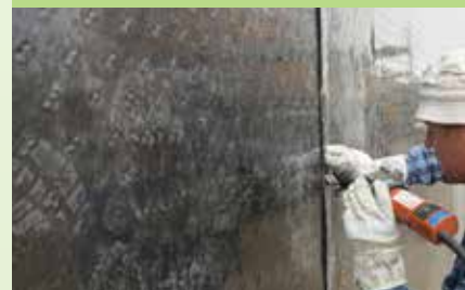
▲ Verschweißen der HDPE-Platten mit Extruderschweißgerät
