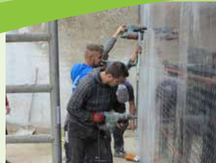
▲ Andübeln an die Bestandswand
