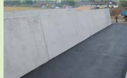
▲ Fahrsilo mit Asphaltboden
