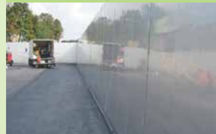
▲ Bei der Montage
