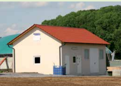
▲ BHKW-Raum mit Trafostation
