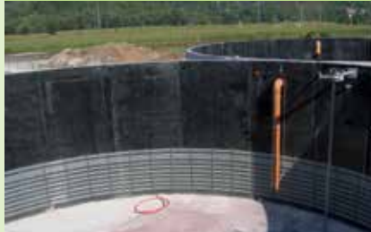
▲ HDPE-Schutzauskleidung & Fermenterheizung
