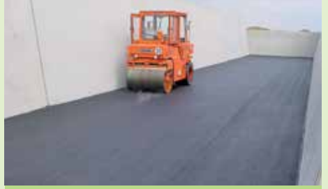
▲ Fahrsilo mit Asphaltboden
