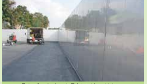
▲ Fahrsilowände mit Edelstahlauskleidung oder mit HDPE-Betonschutzpaletten
