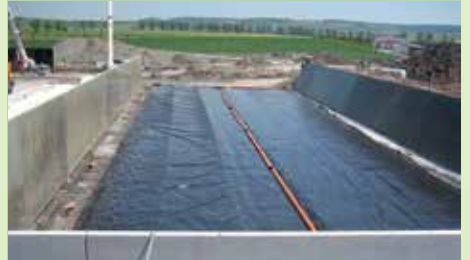
▲ Dichtfolie und Entwässerungsleitung
