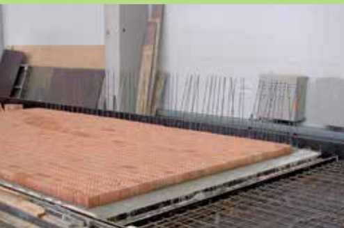
▲ Vorfertigung im Werk
