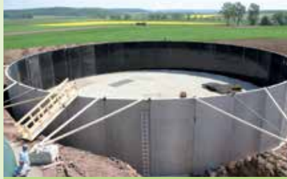
▲ Behälter aus Fertigteilen 36 m Ø
