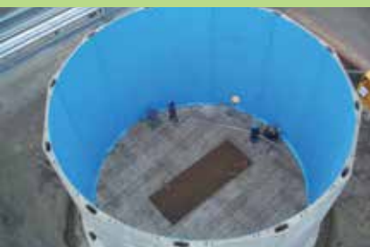
▲ Fertigteilbauweise mit Schutzauskleidung
