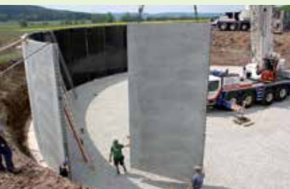
▲ Fertigteilmontage
